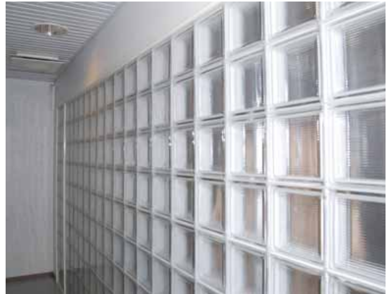
Lasitiiliseiniä rakennettiin kolmanteen kerrokseen vuoden 1996 saneeraustöiden yhteydessä.
