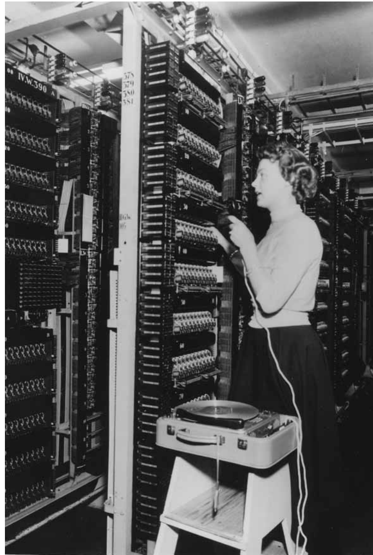
Puhelulaskurien tietoja luetaan keskuksessa dimafonille. Laitteessa oli magneettilevy, johon voitiin taltioida puhetta. (Kuva: Puhelinmuseo / Erkki Lahtinen)
