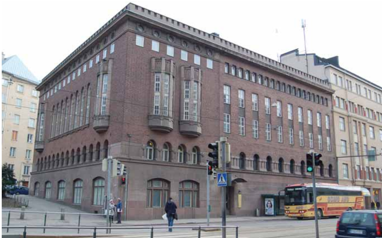
Runeberginkadun puolelta katsottuna talon ensimmäisen ja kolmannen rakennusvaiheen välisen rajan voi havaita esimerkiksi siitä, että 1930-luvulla rakennetun siiven yläkerroksessa ei ole pyöreitä ikkunoita.
