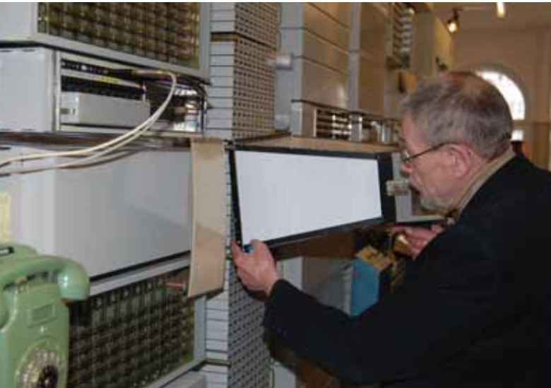
Aikanaan puhelinkeskuksissa valokuvattiin laskurien lukemat erikoiskameralla laskutusta varten. Erkki Lahtinen esittelee kameran käyttöä Puhelinmuseossa.
