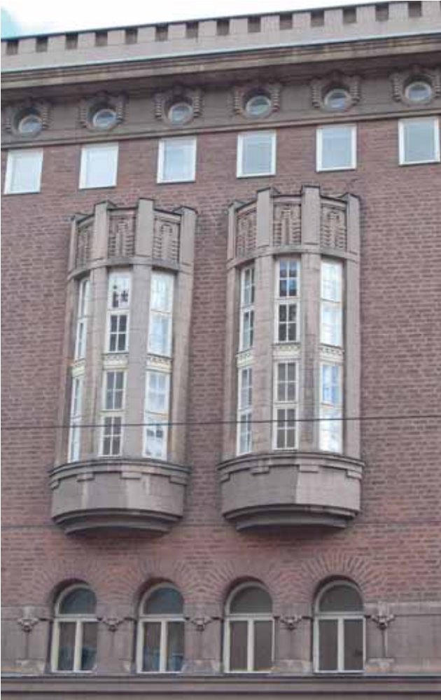
Ulkonevat ikkunat toistuivat hieman erilaisina muunnelmina useissa Lars Sonckin suunnittelemissa rakennuksissa.
