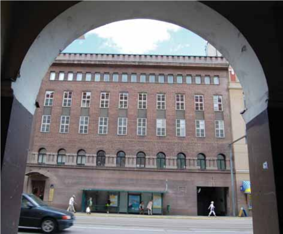
Autohalliin johtava ajoluiskan sisäänkäynti Runeberginkadulla on aivan rakennuksen reunassa.
