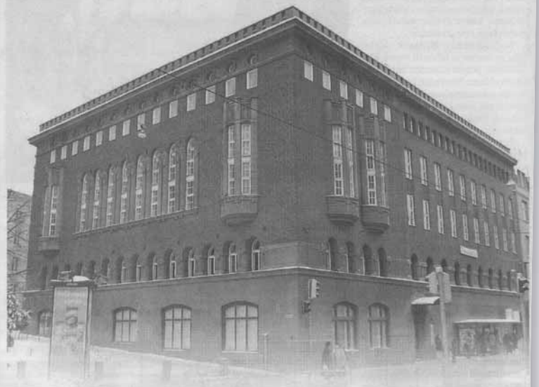
Puhelinmuseo sijaitsee Runeberginkadun ja Apollonkadun kulmassa.
