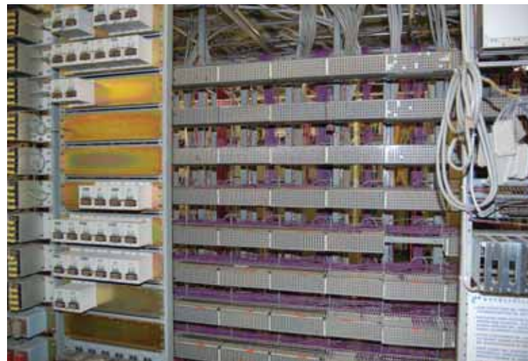
Johtimien kytkeminen ristikytkentärimoihin edellyttää huolellisuutta ja sorminäppäryyttä.
