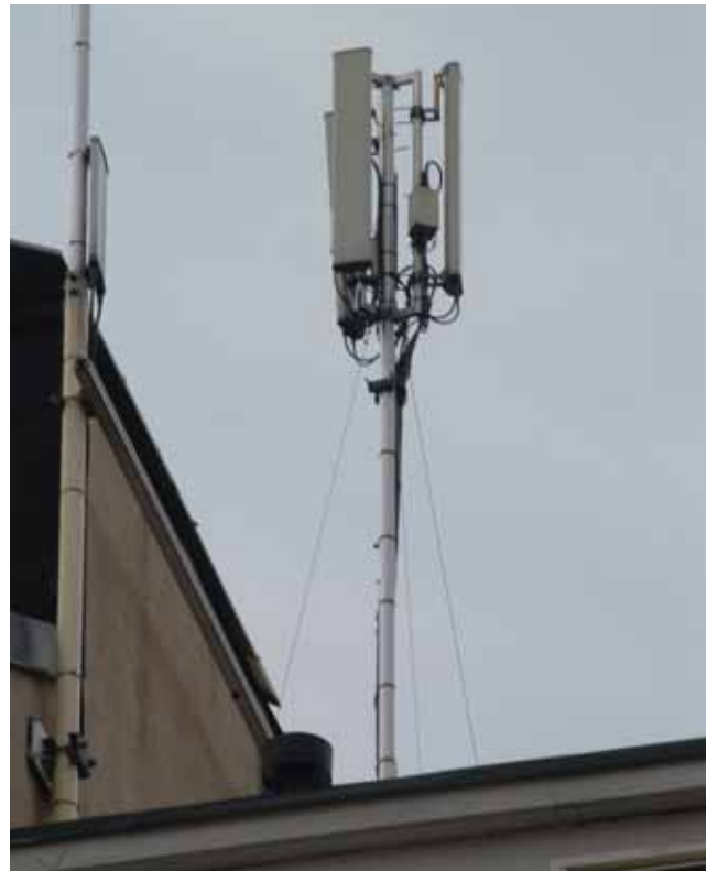
GSM-matkapuhelinten tukiasemamastot on asennettu Töölön keskusrakennuksen katolle.
